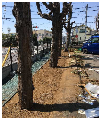
防草シート敷き
